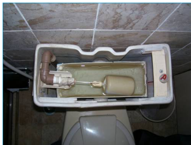
Figura 10 - Caixa instalada no banheiro da suíte do casal.
