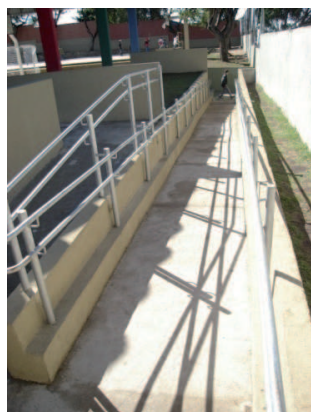
Figura 23 – Foto da rampa de acesso na entrada da escola
