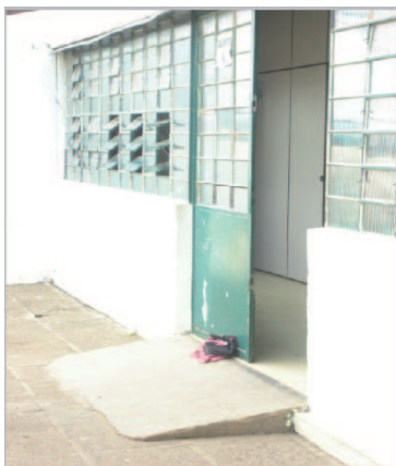
Figura 9 - Foto da rampa na entrada do prédio
