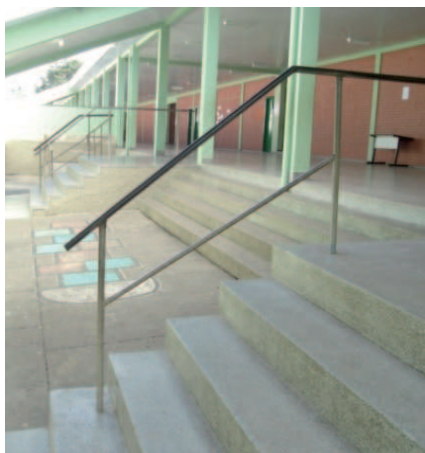
Figura 24 – Foto da rampa de acesso que liga o pátio a quadra esportiva
