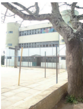
Figura 11 - Foto do prédio de três andares, que não possui elevador
