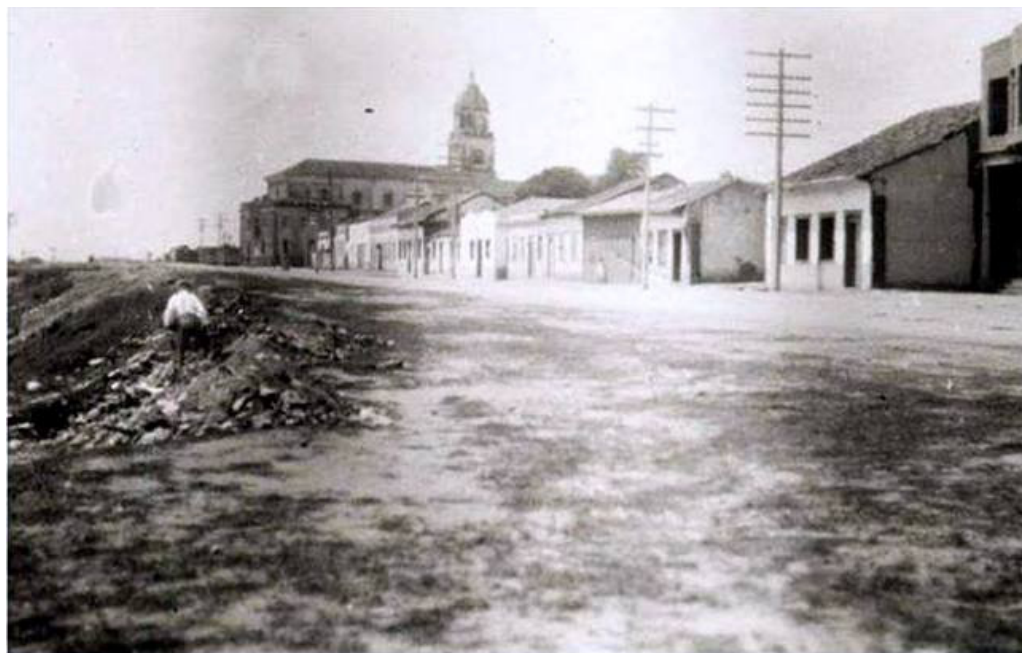
Figura 2 – Rua São José depois da desapropriação, 1939-1940
