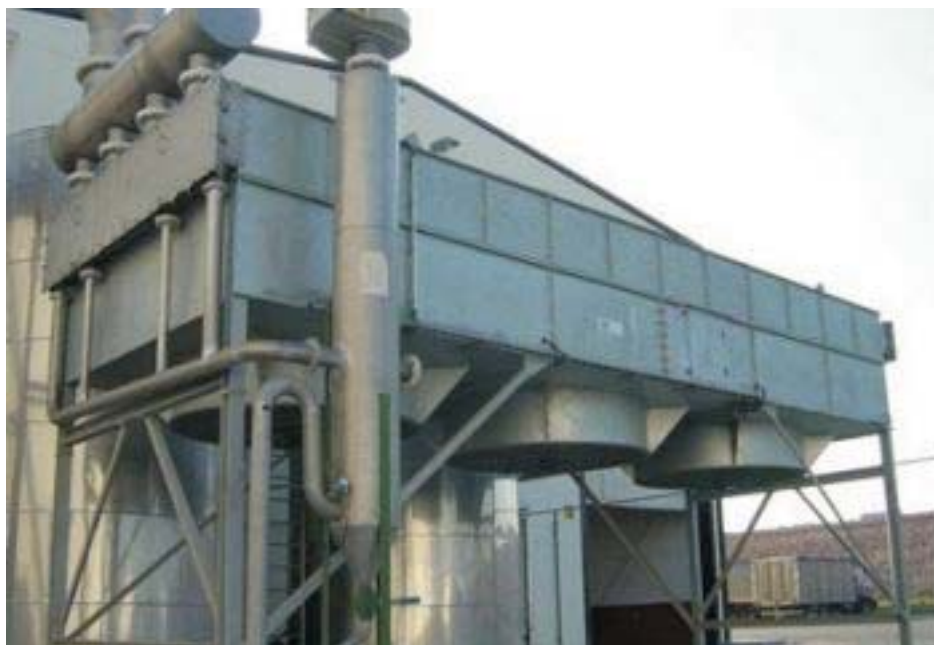
Figura 4 - Condensador de gases aéreo, fabricado pela indústria Tremesa S.A.
