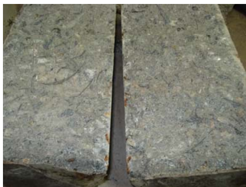
Figura 10: Análise visual da situação das fibras de aço no interior do concreto, após dois anos de ensaio.
