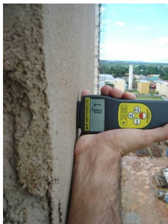
Figura 5 - Medição realizada na fachada norte do 9º andar, ao lado da janela, próximo à fachada oeste
