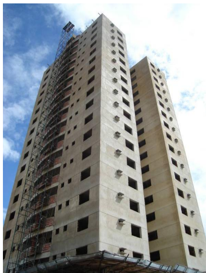
Figura 4 - Edificação onde foram realizadas as medições de umidade
