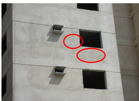
Figura 6 - Regiões da fachada (embaixo e ao lado da abertura da janela) onde foram realizadas as medições de umidade
