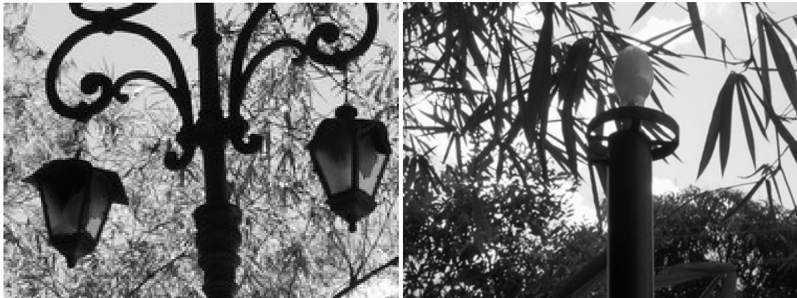
Figura 8 - Luminárias com lâmpadas quebradas na Praça João Luís Ferreira
