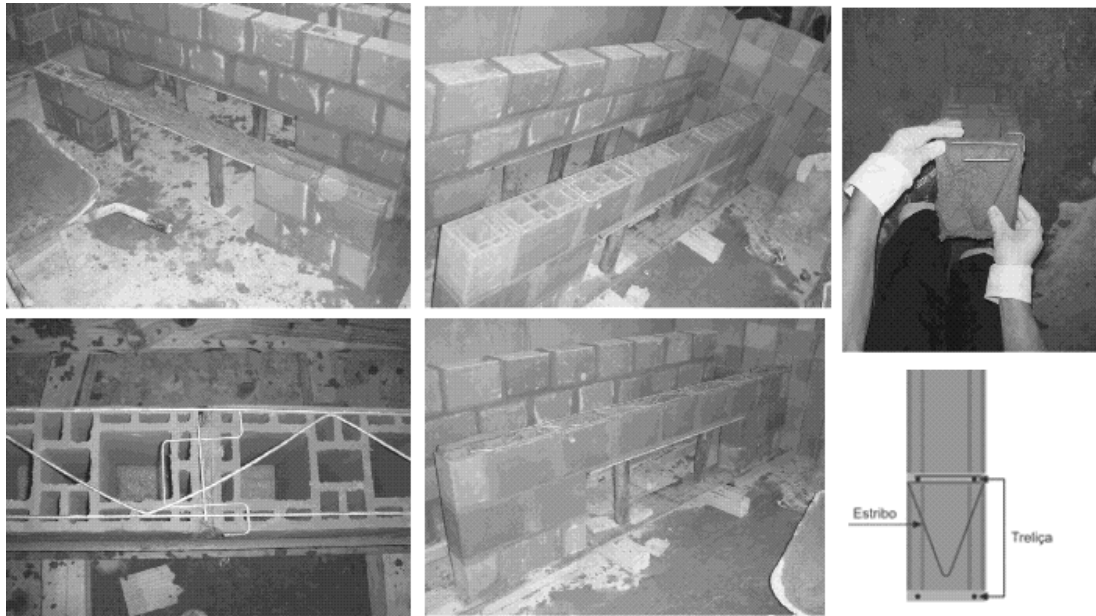
Figura 12 - Execução das vergas do modelo VLT
