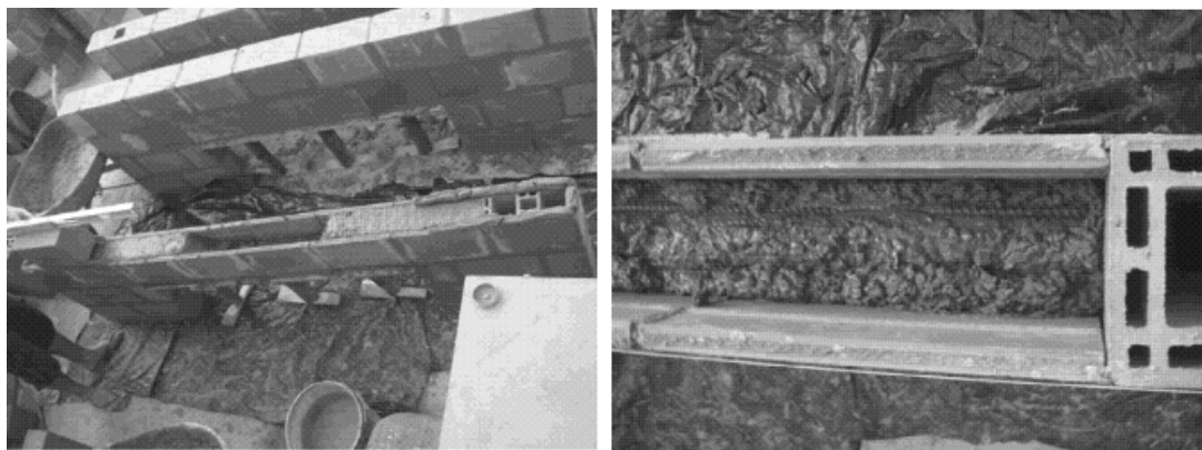
Figura 13 - Execução das vergas do modelo VGL
