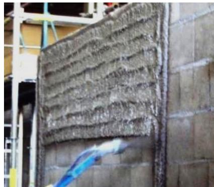
Figura 15 - Argamassa aplicada em uma demão
