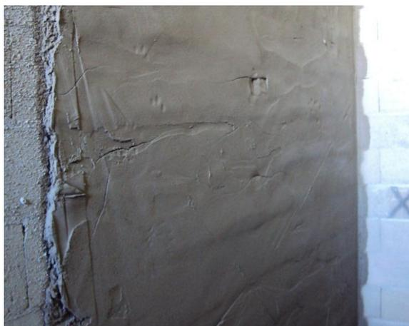
Figura 29 - Escorregamento da camada de argamassa - painel 5L
