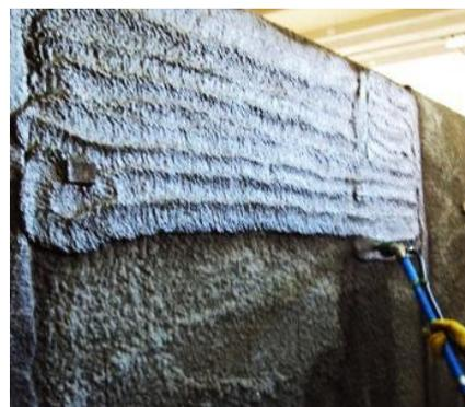
Figura 16 - Argamassa aplicada em duas demãos
