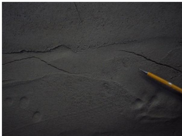
Figura 31 - Fissuras horizontais: escorregamento da camada de argamassa - painel 7L
