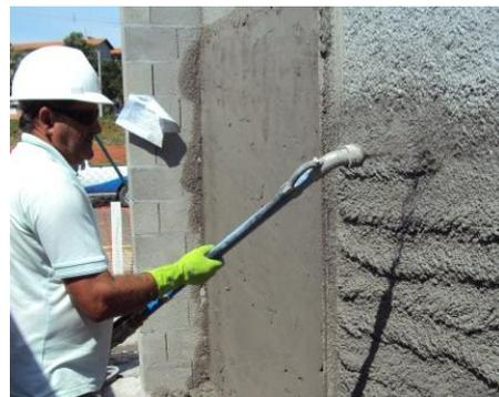
Figura 3 - Projeção mecânica contínua
