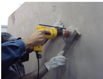
Figura 20 - Corte a seco
