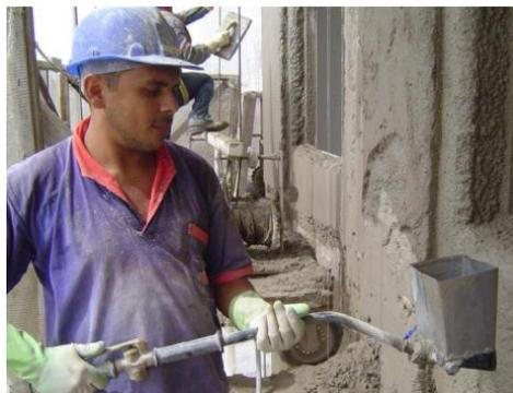
Figura 2 - Projeção por *spray* a ar comprimido
