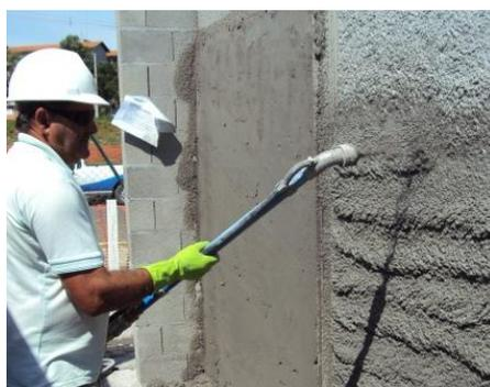
Figura 19 - Aplicação com projeção mecânica
