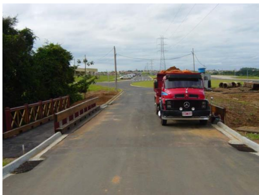
Figura 1 – Vista da ponte multicelular de madeira protendida
