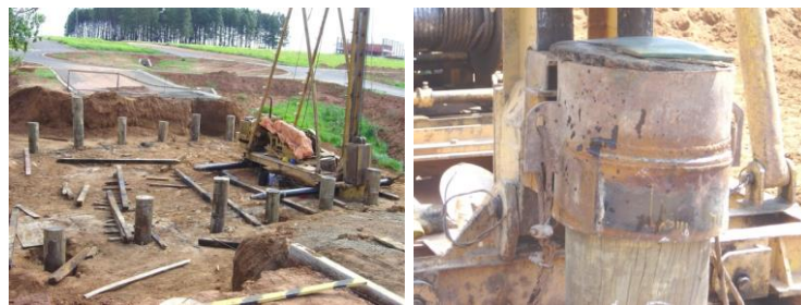
Figura 2 – Bate-estacas com martelo e capacete
