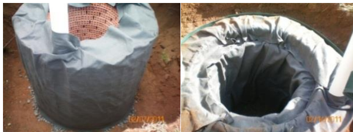
Figura 4- Manta geotêxtil colocada nas paredes internas e externas do poço de infiltração
