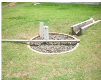
Figura 6- Tubo de 150 mm de PVC para coleta de dados (poço de monitoramento)
