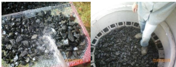
Figura 8- Lavagem da brita para utilização dela no fundo e na tampa do poço
