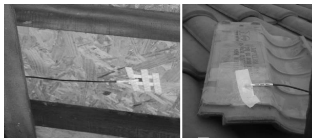
Figura 3 - Sensores de temperatura superficial fixados sob a (a) cobertura verde e uma (b) telha cerâmica
