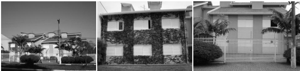
Figura 6 - Edifícios de estudo e fachada com e sem trepadeira
