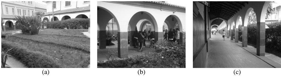
Figura 3 - Galeria de circulação da unidade-caso
