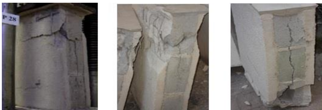
Figura 17 - Ruptura dos prismas com revestimento, com tela e conectores: prismas distintos
