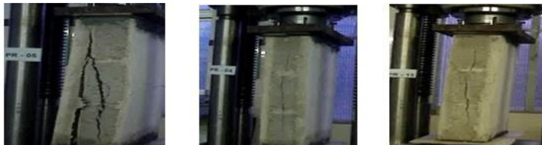
Figura 15 - Ruptura dos prismas de blocos de concreto com revestimento, sem tela: prismas distintos
