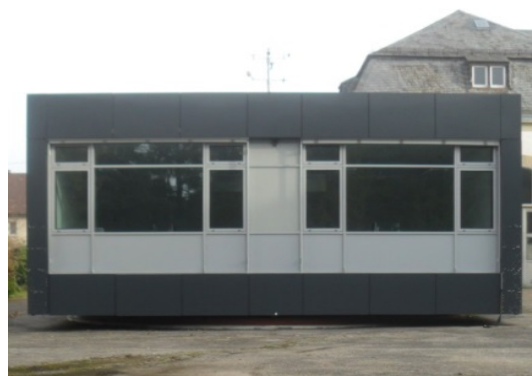
(b) Vista da fachada envidraçada
