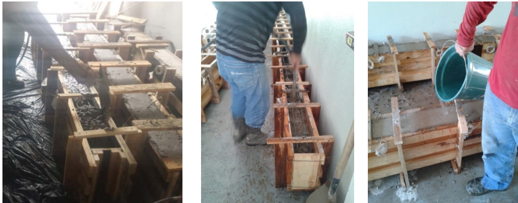
Figura 5 - Lançamento, adensamento e cura das vigas
