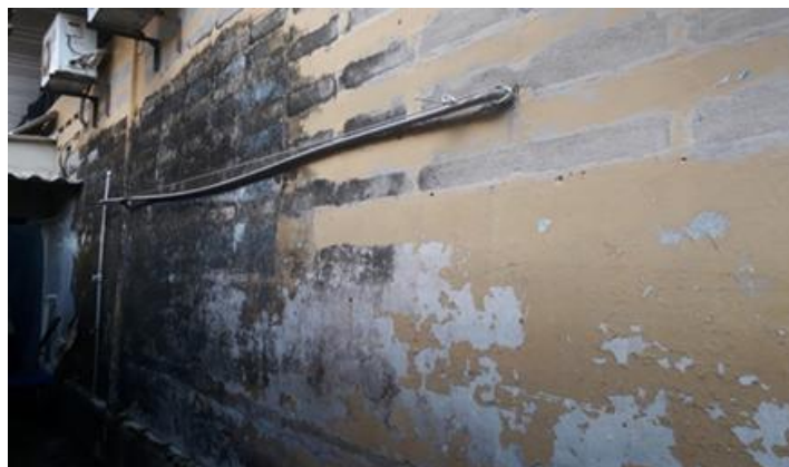
Figura 10 - Parede externa do LACC
