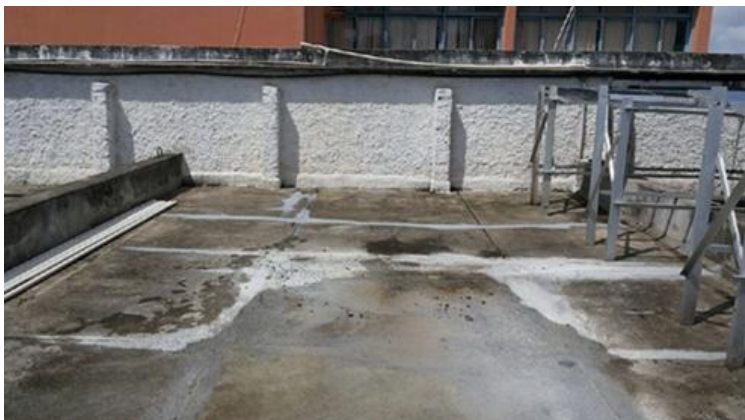
Figura 2 - Laje do edifício das salas do LIE
