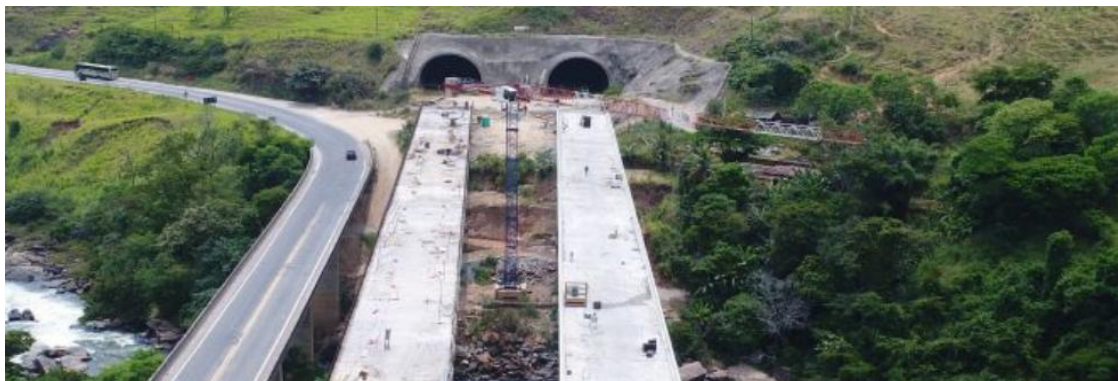
Figura 2 - Ligação entre pontes e túneis no trecho escolhido para a pesquisa (11/03/19)
