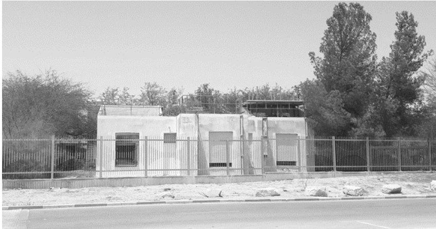
Figura 1 - Fachada sul da edificação-teste
