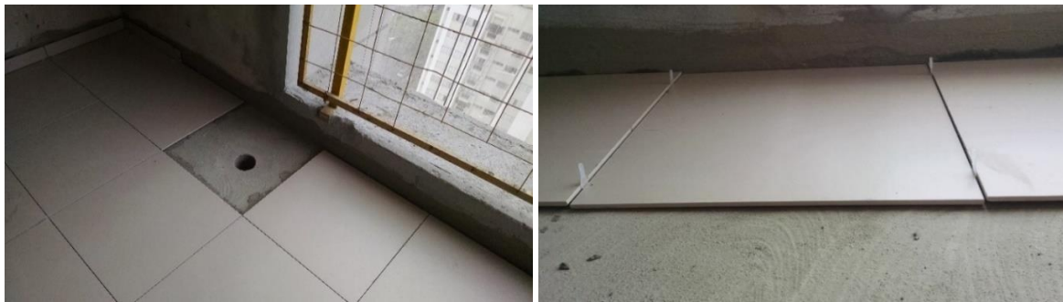
Figura 8 - (a) Execução do piso assentado sobre o ralo após o assentamento do restante da área; e (b) colocação temporária de peças sem argamassa nos locais onde será executado o piso diamantado
