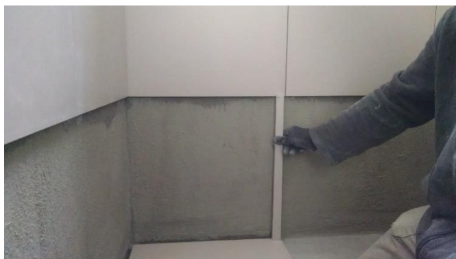
Figura 4 - Verificação da inclinação do piso
