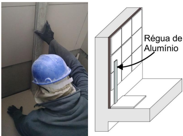
Figura 5 - Verificação do cobrimento do piso pelo azulejo
