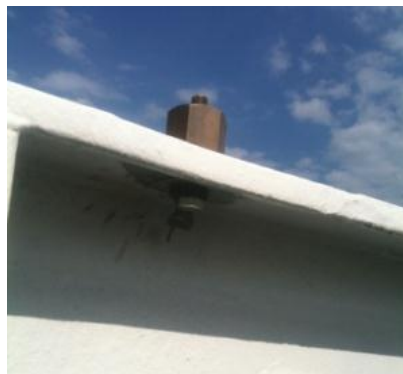
Figura 4: Suporte metálico para instalação da antena ao guarda-corpo do passadiço
