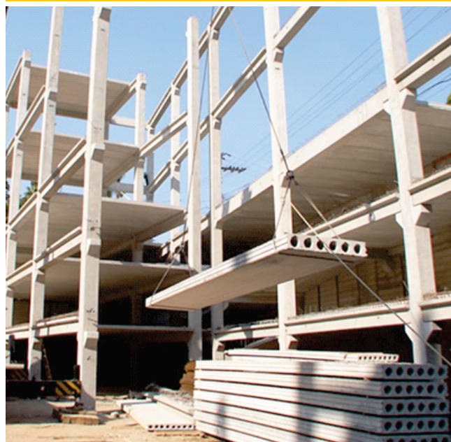
Figura 1 – Pavimento formado por lajes alveolares
