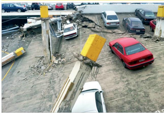
Figura 2 - Teoria da fissura crítica de cisalhamento (adaptado de Moraes Neto (36))
