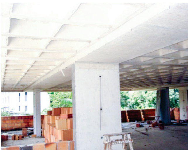
Figura 1 Enrijecimento da ligação laje-pilar através de viga-faixa
