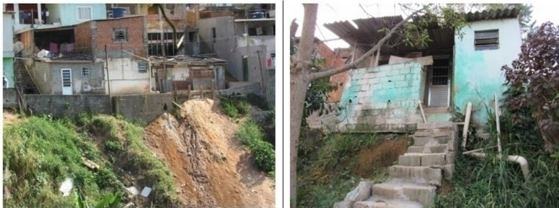
Figura 2 - (Esquerda) Lançamento de águas servidas e pluviais na meia encosta - Vila Josefina, Franco da Rocha. Fonte: LabGRis, 2018. (Direita) Infraestrutura precária de coleta de águas servidas - Vila Josefina, Franco da Rocha. Fonte: LabGRis, 2018.
