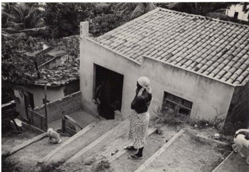
Figura 6 – Ladeira no Brongo do Pau Miúdo, foto realizada durante o levantamento por parte de equipe coordenada pelo arquiteto Sylvio Sawaya. Fonte: acervo do arquiteto Sylvio Sawaya.
