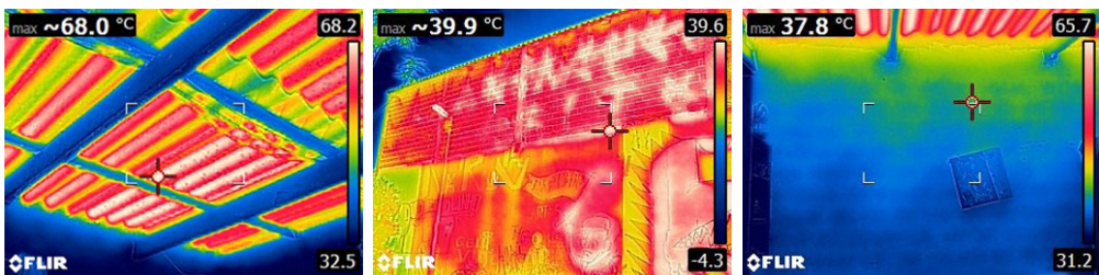
Figura 11 – Montagem com fotos termográficas da casa 4
