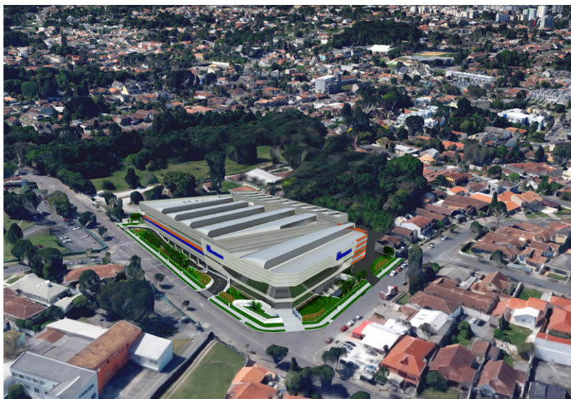
Figura 4 – Simulação da vista aérea da implantação da loja Angeloni no Bom Retiro
