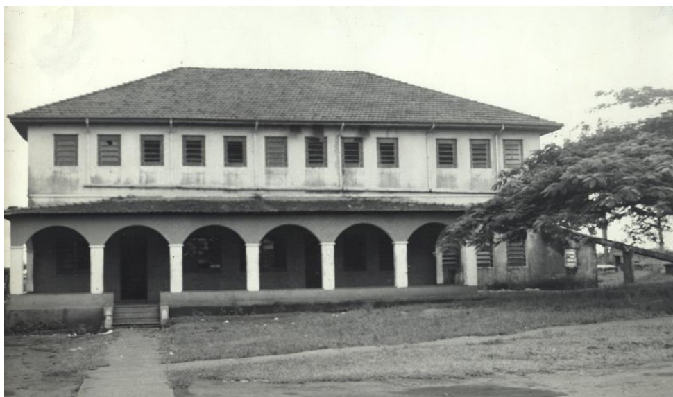
Figura 1. Prédio do internato feminino ISG. Fonte: Instituto Samuel Graham (1957).
