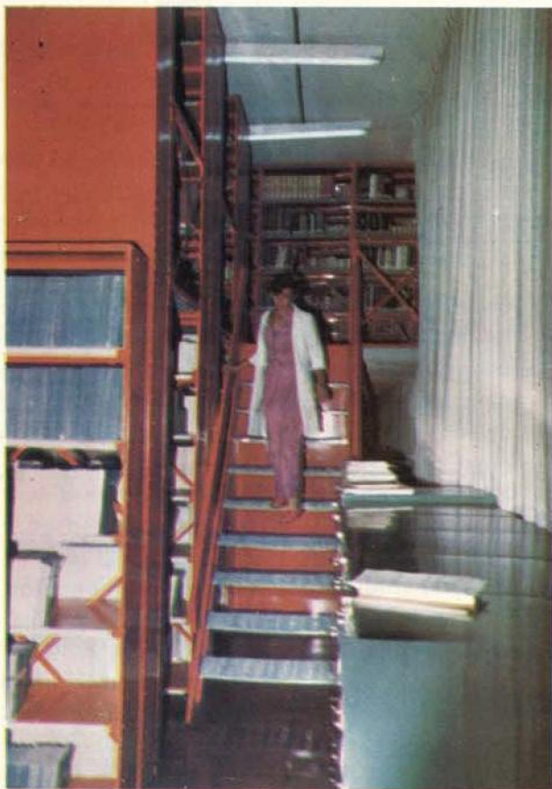
Fig. 2 — Pavilhão do Acervo, parte interna, aparecendo a estrutura metálica de dois pisos.
