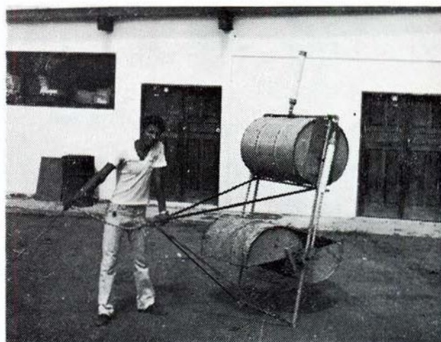
Fig. 1 — Bomba acionada por um rotor Savonius submerso, vista geral.
