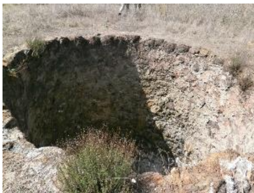
Figura 4 - Forno tradicional de Trigaches, em Beja, próximo da pedreira e de materiais combustíveis para a lenha utilizada - forno desativado
