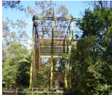
(b) Recintos de malha metálica
