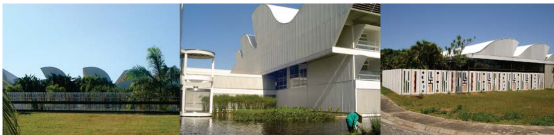
Figura 2 - Sheds com formatos aerodinâmicos projetados por Lelé
