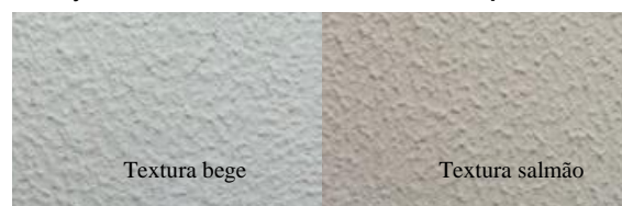
Figura 4 - Superfícies da edificação analisadas em testes com o espectrômetro Alta II
