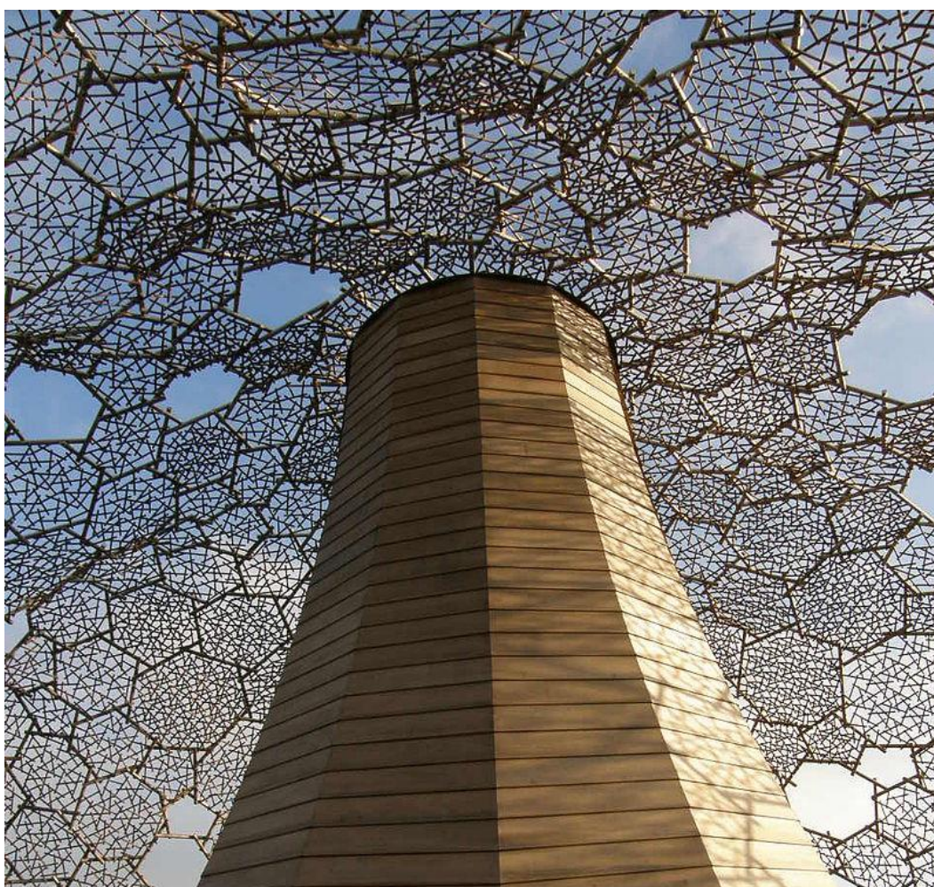
Figura 6 - Elemento externo do observatório no monte Rokko-Shidare
