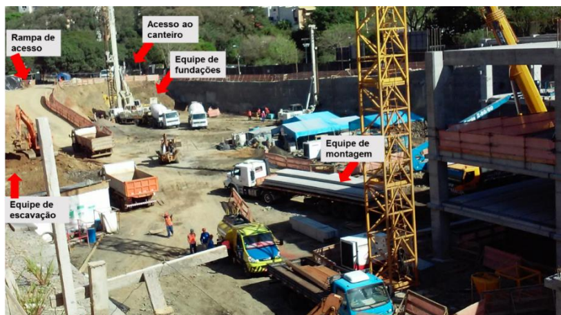
Figura 4 - Visão geral do canteiro de obras
