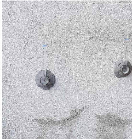
Figura 3 - Ensaio de permeabilidade à água
