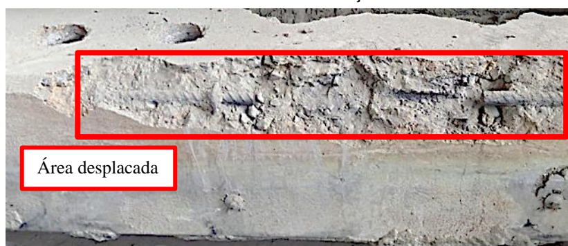
Figura 9 - Local da retirada dos testemunhos das barras de aço
