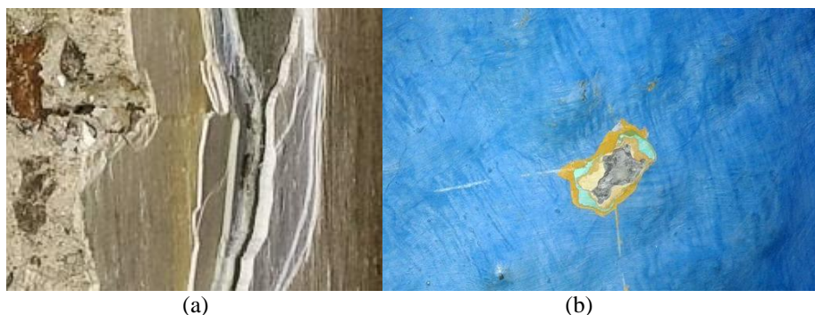
Figura 3 – Capas superpuestas de pintura a la cal en Medina de Tetuán, Marruecos
