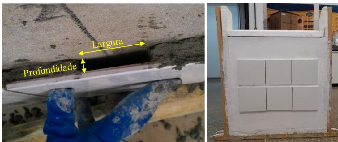
(a) Construção do defeito
