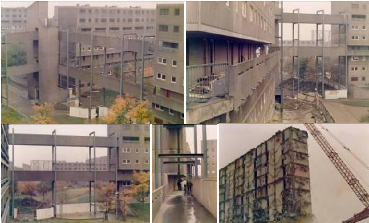
Figura 1 - Conjunto habitacional Killingworth em processo de demolição
