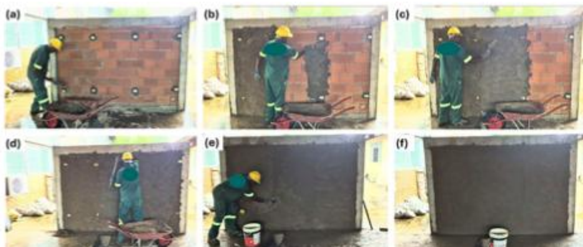
Figura 5 - Etapas de execução do revestimento dos painéis: (a) taliscamento; (b) aplicação da argamassa; (c) aperto da argamassa com colher de pedreiro; (d) sarrafeamento; (e) desempeno; (f) painel revestido
