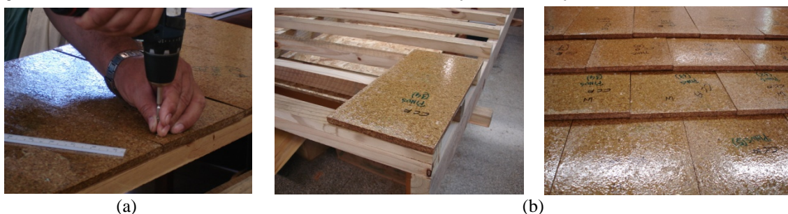
Figura 2 - Painéis sendo fixados (a), estrutura de madeira e painéis sobrepostos (b)
