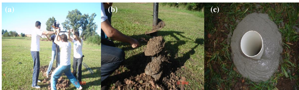
Figura 1. Utilização do trado mecânico para construção dos poços de monitoramento.
