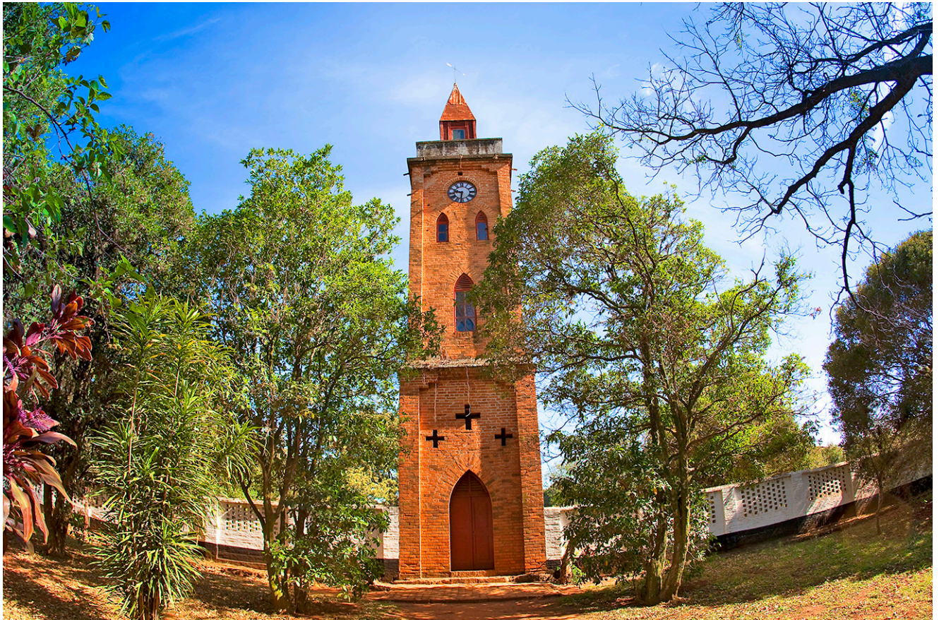
Figura 19 – Torre do relógio com mirante. Arquivo Fotográfico Fazenda Ibicaba – Século XXI. Fotos de Alexandre Kantowitz – V.D.R. Fotografias. Acervo Carlota Schmidt Memorial Center. Fotografia cedida por José Eduardo Heflinger Jr., diretor do Carlota Schmidt Memorial Center, quando da visita do autor a Limeira em outubro de 2014.
