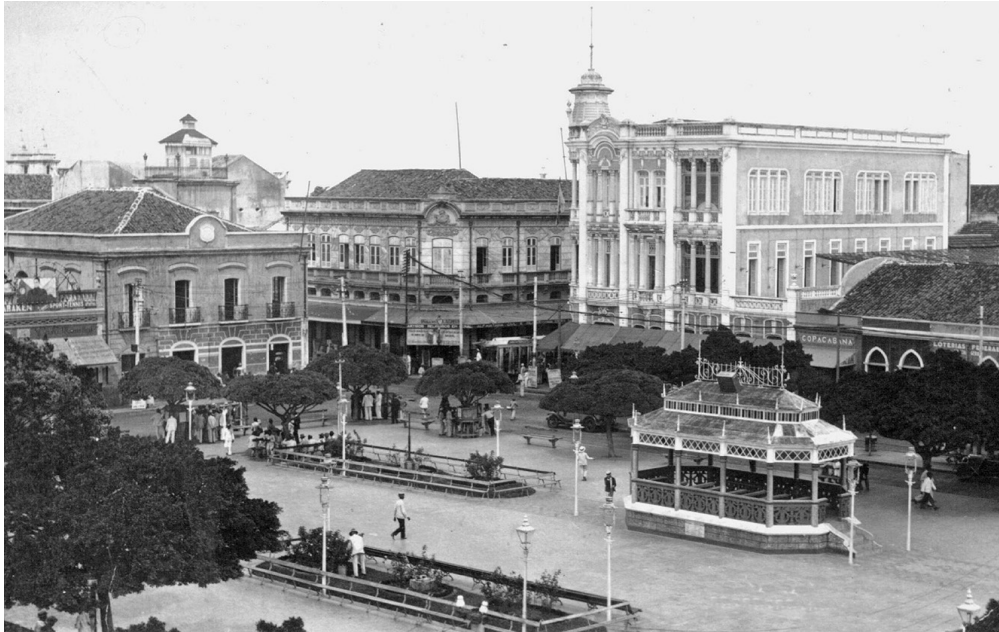
Figura 10 – Praça do Ferreira (antes Jardim 7 de Setembro da Praça do Ferreira) após a remodelação de 1925, podendo-se notar o coreto e a ausência do sistema cata-vento/cacimba/caixa-d'água, Fortaleza. Coleção Nirez, Fortaleza.
