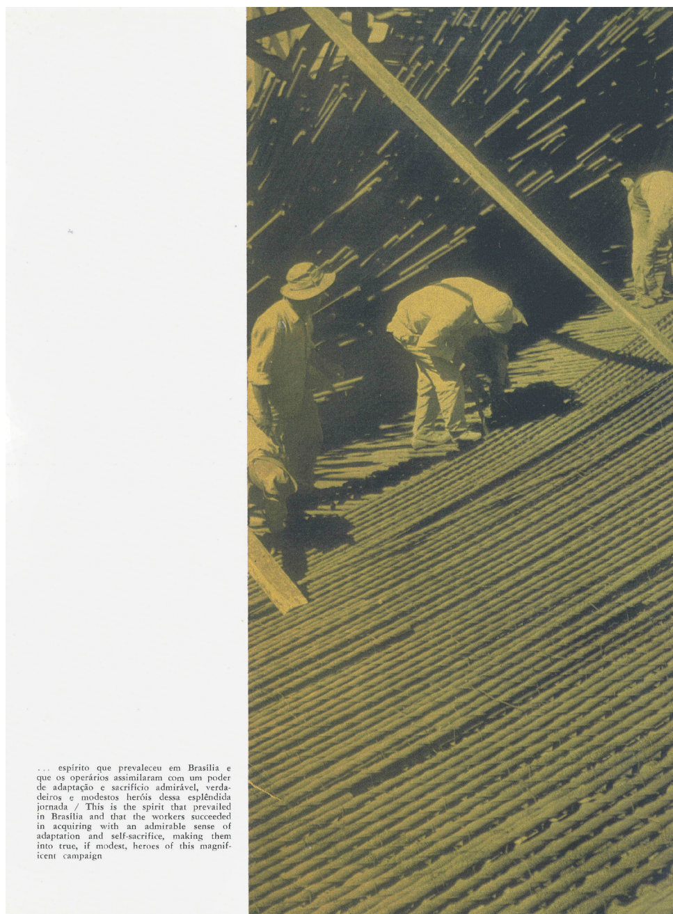
Figura 35 - Fotografia de Marcel Gautherot do interior da cúpula convexa do Congresso Nacional, Módulo nº 18 , junho de 1960.
