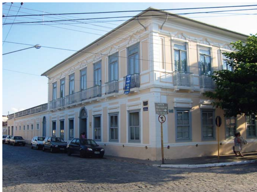
Figura 34 – Residência do conde de Moreira Lima. Aspecto exterior. Fachada para a rua da Viscondessa. Fotografia da autora, 2004, Lorena, SP.
