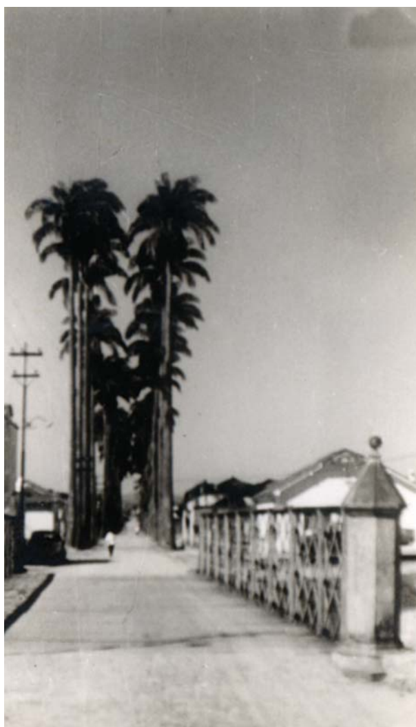
Figura 26 – Rua das Palmeiras e ponte metálica. Fotografia, c.1940, Lorena, SP. 7,8 x 13,1 cm. Acervo da autora.
