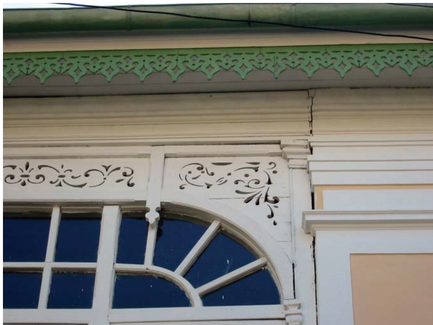
Figura 33 – Residência do conde de Moreira Lima. Detalhe onde se distingue o encontro do corpo original do edifício e do acréscimo executado na reforma da década de 1880. Fotografia da autora, 2004, Lorena, SP.
