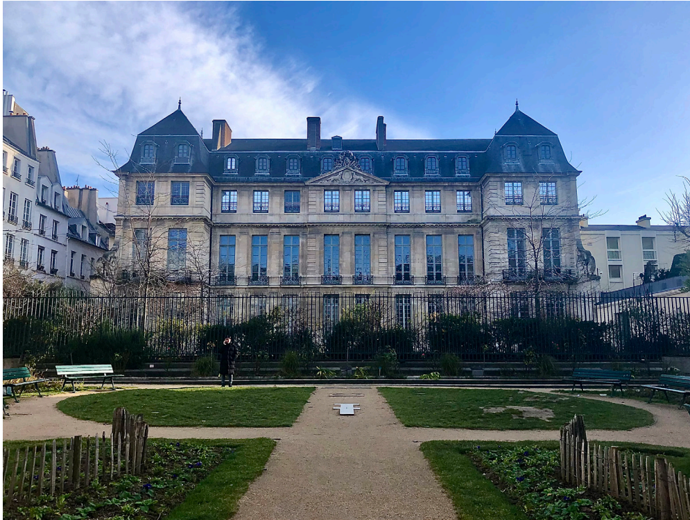
Figura 29 – O edifício depois da restauração realizada na década de 1970. Foto: Maria Regina Weissheimer.
